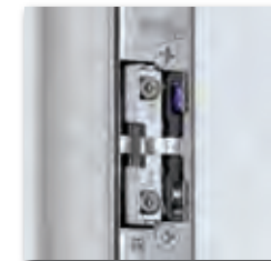
Die neue Tagesfalle an der Schliebleiste
